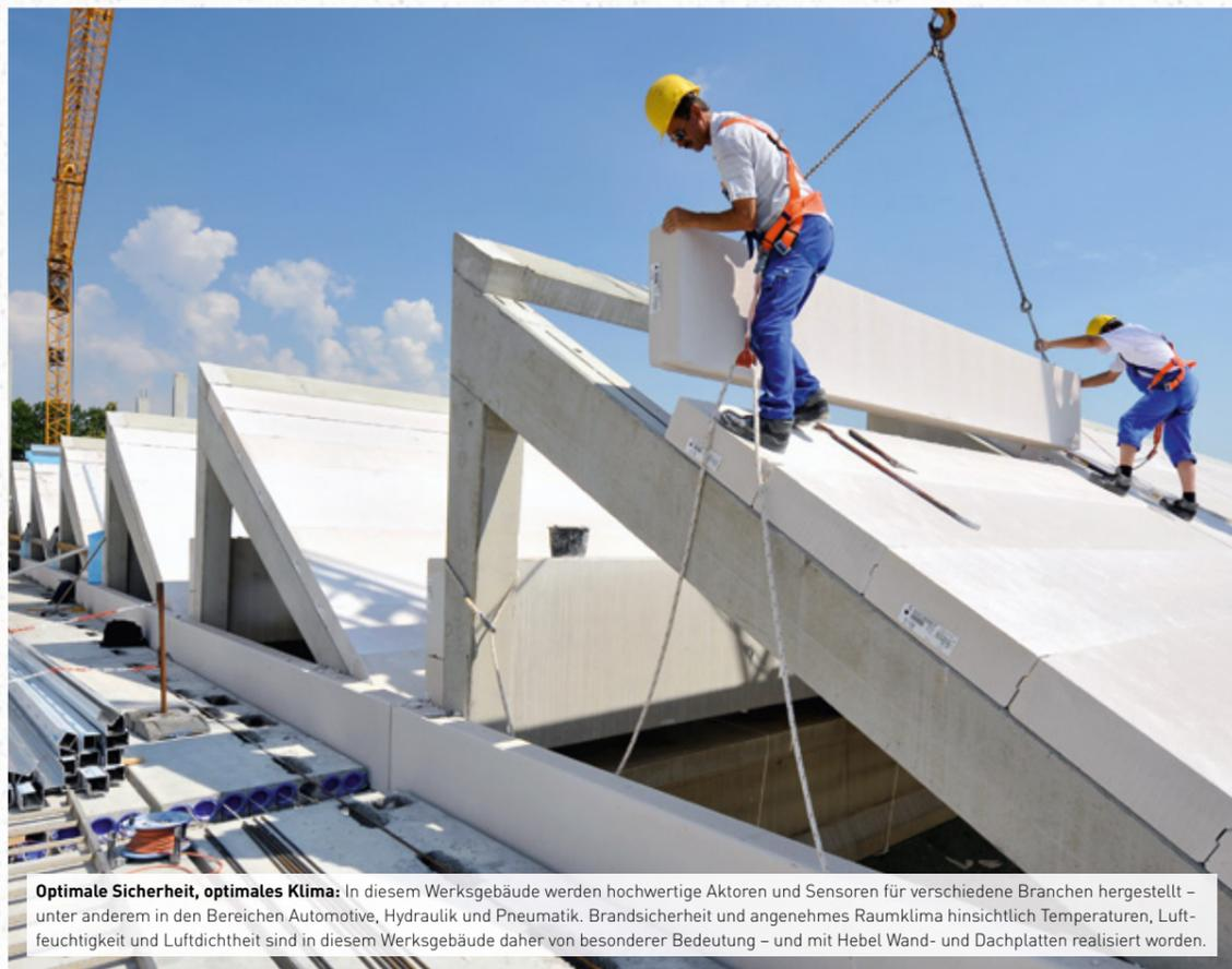
**Optimale Sicherheit, optimales Klima:** In diesem Werksgebäude werden hochwertige Aktoren und Sensoren für verschiedene Branchen hergestellt – unter anderem in den Bereichen Automotive, Hydraulik und Pneumatik. Brandsicherheit und angenehmes Raumklima hinsichtlich Temperaturen, Luftfeuchtigkeit und Luftdichtheit sind in diesem Werksgebäude daher von besonderer Bedeutung – und mit Hebel Wand- und Dachplatten realisiert worden.
