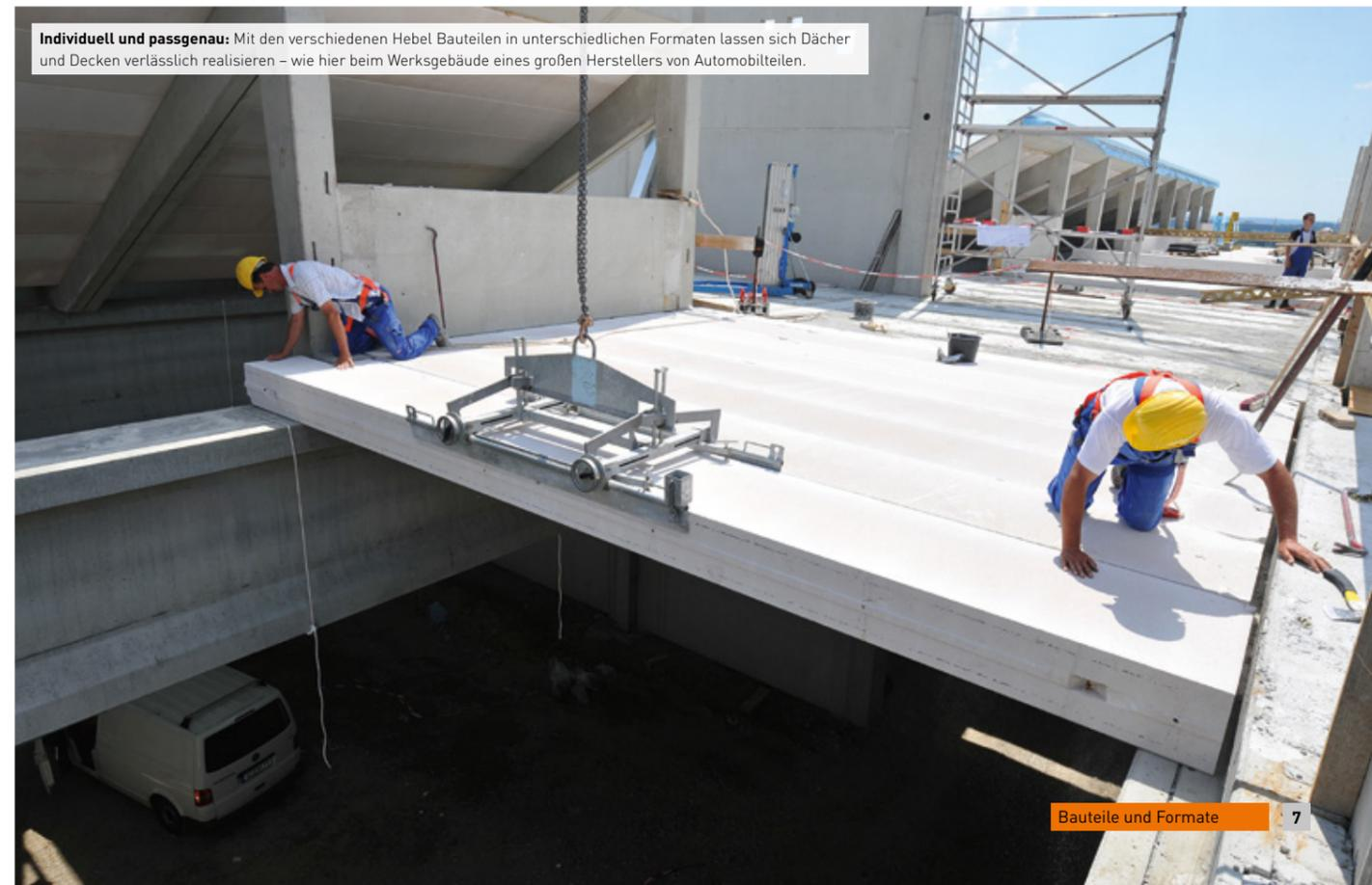
**Individuell und passgenau:** Mit den verschiedenen Hebel Bauteilen in unterschiedlichen Formaten lassen sich Dächer und Decken verlässlich realisieren – wie hier beim Werksgelände eines großen Herstellers von Automobilteilen.
